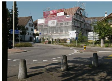
Erneuerung Dach Fassaden
