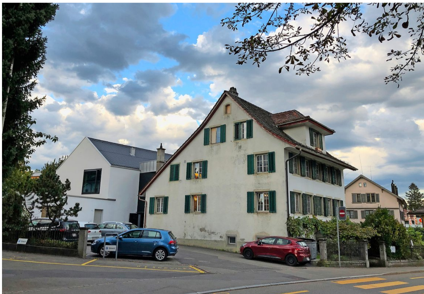
Neues Ober- und neues Dachgeschoss: Das alte Rebbauernhaus soll für die Musikschule nutzbarer gemacht werden. Foto: Christian Dietz
