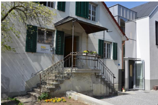
Abb. 1: Eingangsbereich. Denkmalgeschützte zweiläufige Aussentreppe zum Rebbauernhaus, sowie neuer Eingang zum gemeinsamen Treppenhaus mit dem neuen Werkstattgebäude
