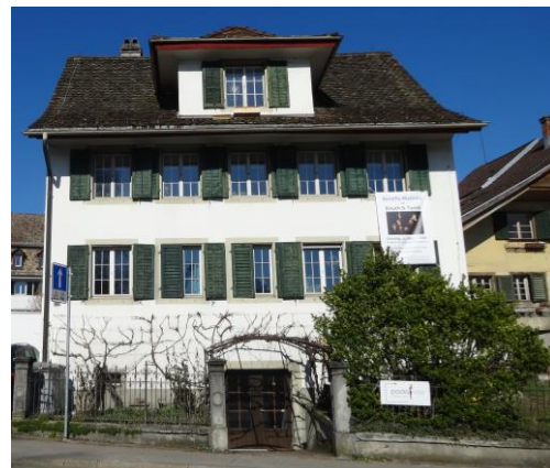
Abb. 2: Ansicht von Süden mit Eingang in den Klavierraum im Untergeschoss, der zu einem Gruppenraum erweitert werden soll
